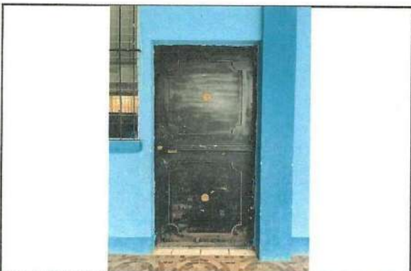
Foto 3: MEJORAMIENTO DE PINTURA EN PUERTAS.
